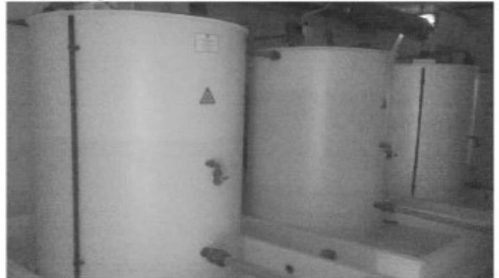
Fig. 5. Cuves de stockage et de décroissance des effluents liquides radioactifs
