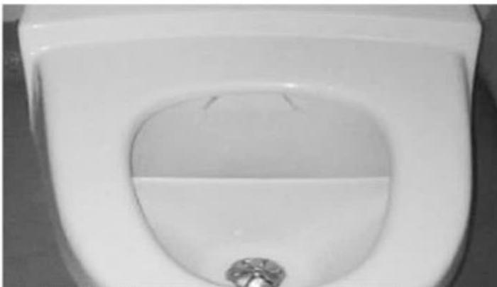
Fig. 4. Toilettes à double compartiment d'une chambre de radiothérapie métabolique, reliées aux cuves de décroissance
